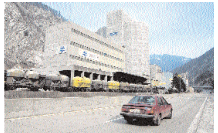
Des entreprises comme Bienna Interfloor Sonceboz SA et Ciments Vigier (photo) réinventent le mot intégration. (a)
